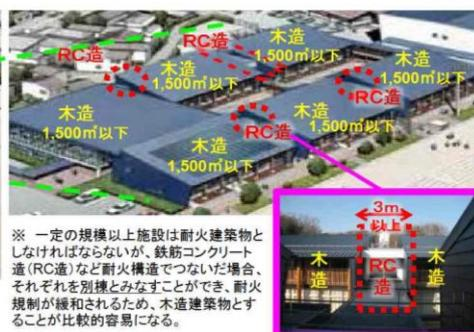
※ 一定の規模以上施設は耐火建築物としなければならないが、鉄筋コンクリート造(RC造)など耐火構造でつないだ場合、それぞれを別棟とみなすことができ、耐火規制が緩和されるため、木造建築物とすることが比較的容易になる。
