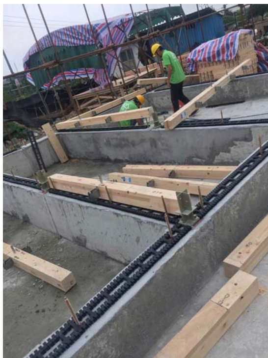
防腐防蟻を重視した基礎、土台等の施工
