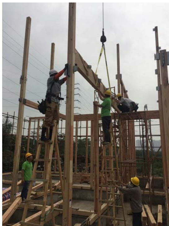
2階建ての軸組構造躯体の組立
