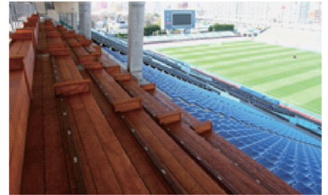
KINCHO 体育馆（日本大阪）、长椅（越秀木 -PL 户外木地板、越秀木 -DT 深层炭化木）
