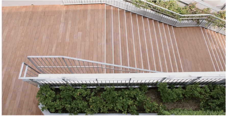
用越秀木 -PL 户外木地板进行铺装的某小学的楼梯。能够呈现出适度的柔和感，在小朋友嬉戏跑跳时，能起到缓冲作用，能够对于摔倒等事故防患未然。
