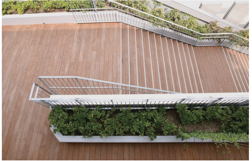
마쿠세림이 처리된 초등학교 계단. 적당한 유연함이 있고 뛰어다녀도 충격이 완화되어 굴러 넘어져도 사고를 예방할 수 있음
