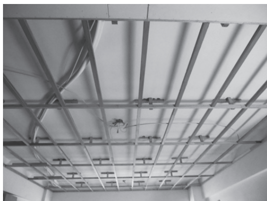
写真2 天井の棧材に使われるLVL
