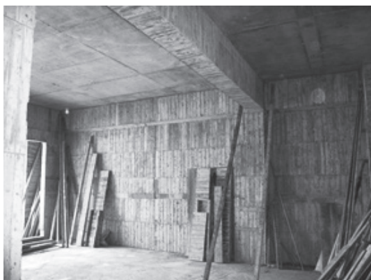
写真1 壁は型枠用製材板により、床と天井は型枠用合板によりコンクリート施工
