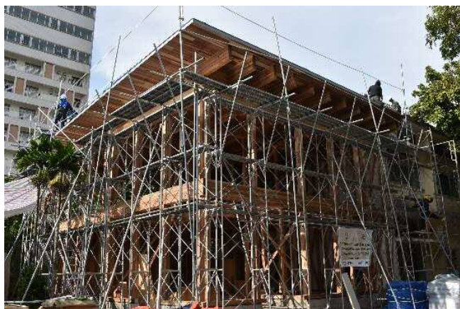
図 2. IBST 木造モデル施工木工事様子
