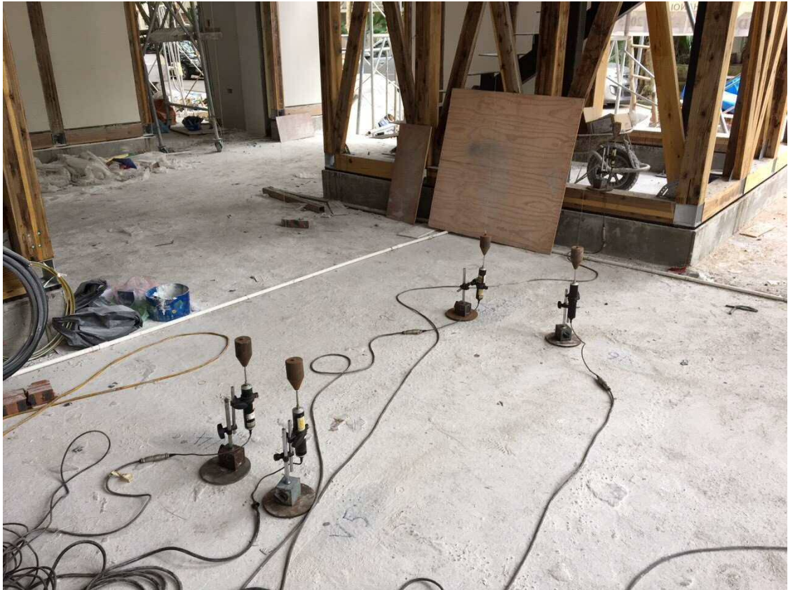
荷重試験での変位計の配置
