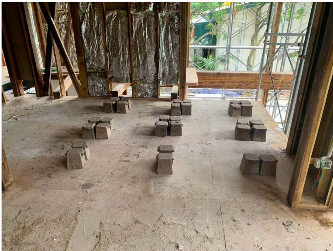
荷重試験対象のフロアセルに荷重をかける。荷重レベル：33%P tn
