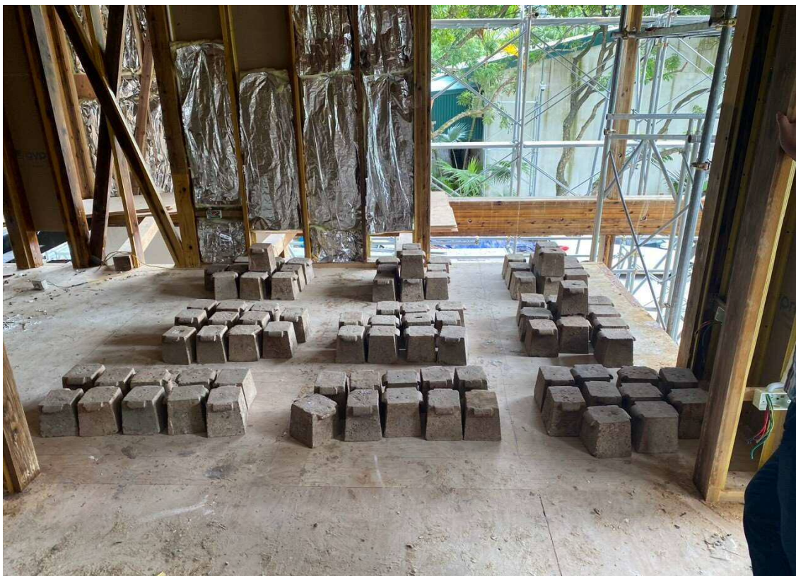
荷重試験対象のフロアセルに荷重をかける。荷重レベル：100%P tn
