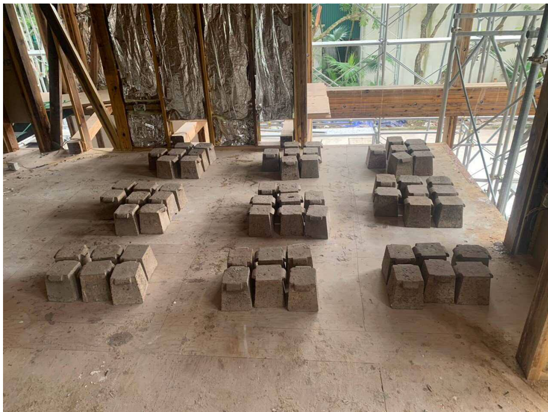
荷重試験されるフロアセルの下の領域。荷重レベル：67%P tn
