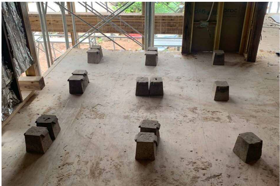
荷重試験対象のフロアセルに荷重をかける。荷重レベル：17% P_{tn}
