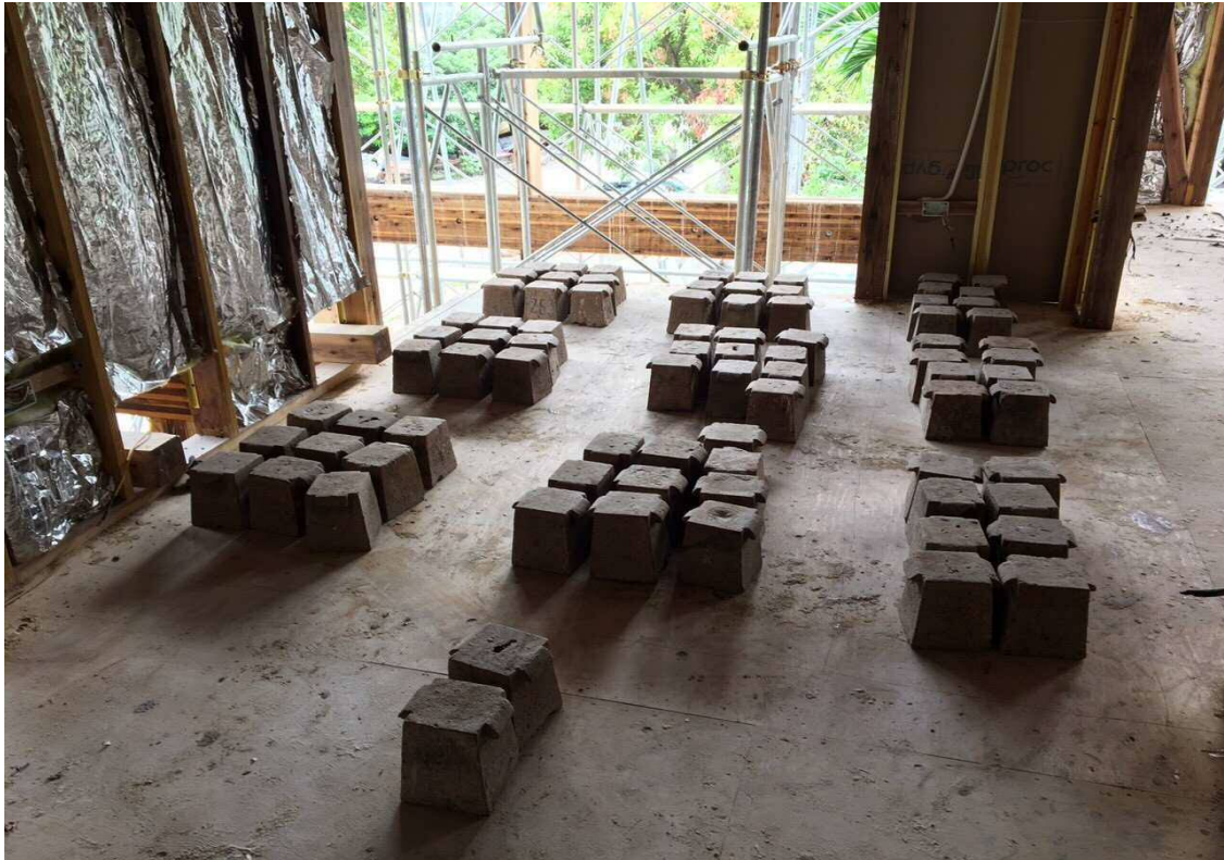
荷重試験対象のフロアセルに荷重をかける。荷重レベル：83%P tn
