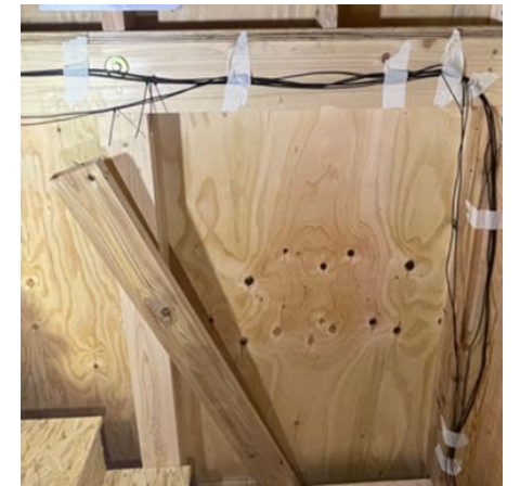
図3：間柱の脱落
