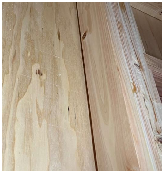
図7：間柱と壁パネルの分離
