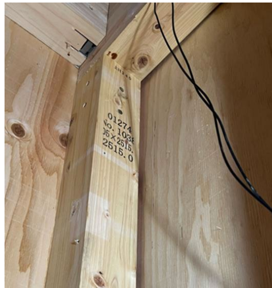
図9：間柱とせん断壁の分離
