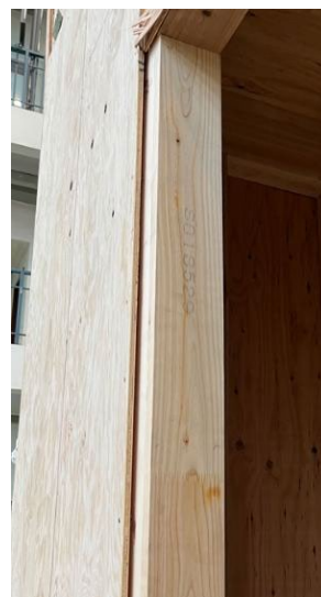
図6：間柱と壁パネルの分離
