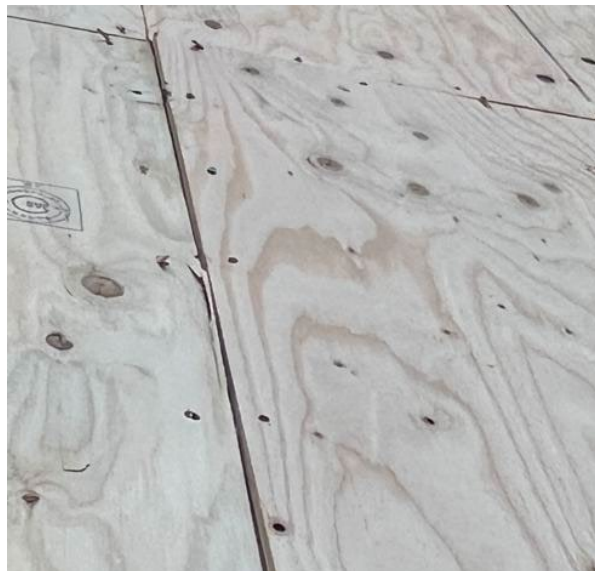
図9：間柱とせん断壁の分離
