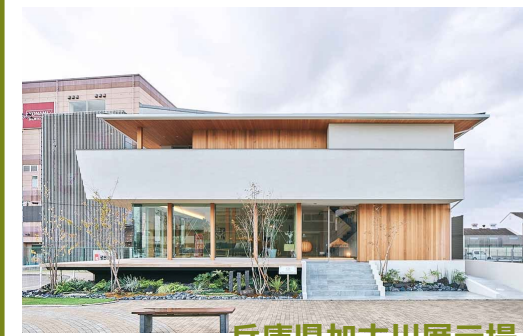
兵庫県加古川展示場
