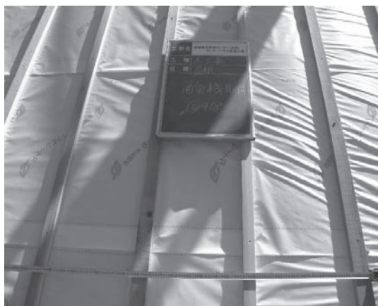
写真 9.37 透湿防水シートと桟木の施工
