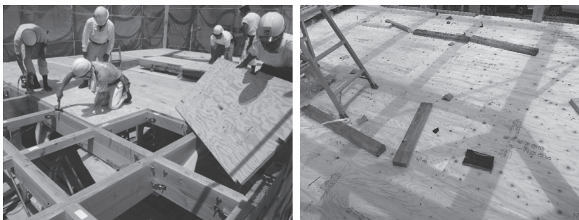
写真 9. 30 2 階床板の施工
