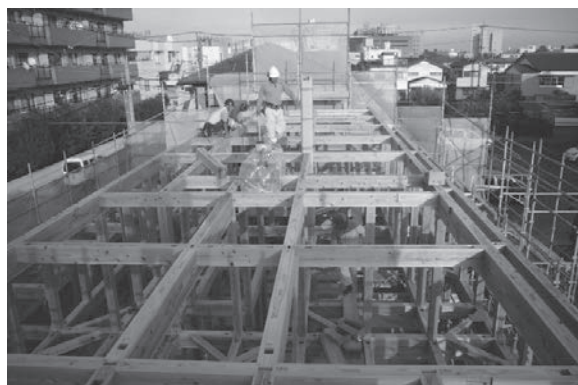
写真 9. 33 小屋梁の施工
