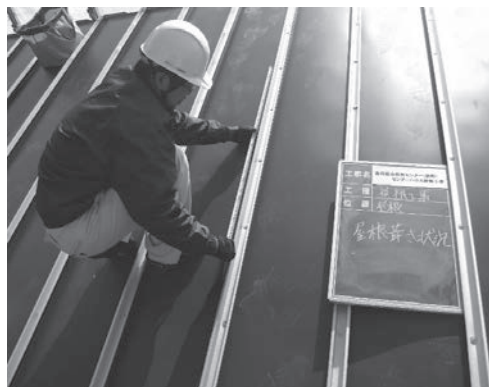
写真 9.39 屋根葺き材の施工
