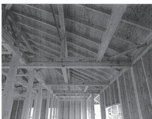
図 3.3 躯体完成時内部写真：小屋組
