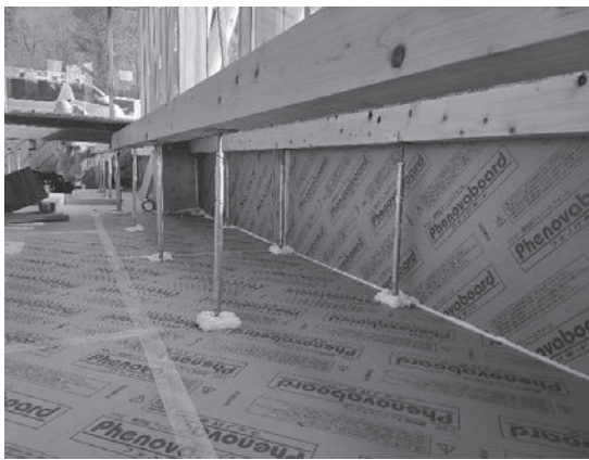
写真 9.40 床下断熱材
