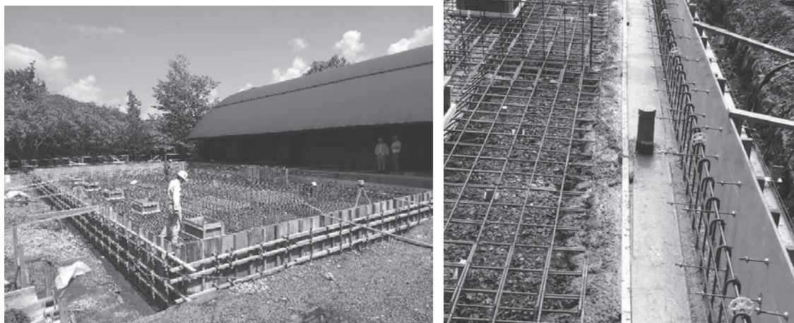
写真 9.1 外周型枠と配筋作業
