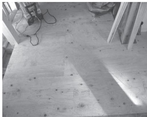
写真 9.47 床材（構造用合板）
