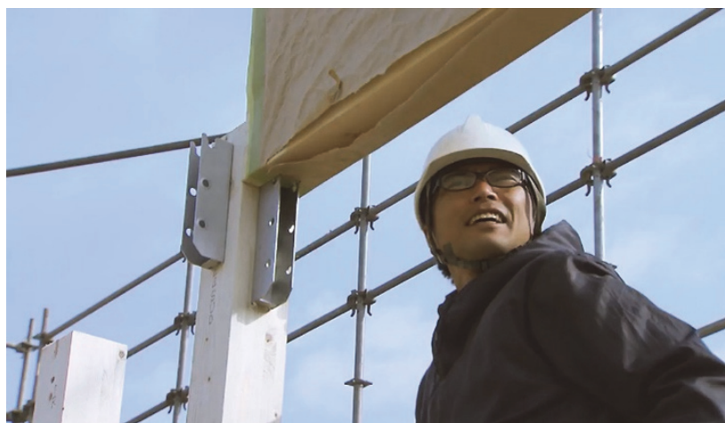
写真 5.3 梁受け金物に横架材を取付け
