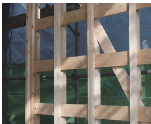
図 1.2 貫（風圧力や地震に抵抗する）
