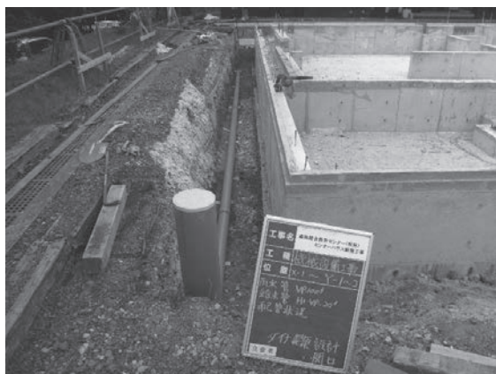
写真 9.12 外部配管の敷設
