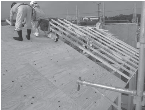
写真 9.36 屋根下地の野地板（構造用合板）の施工
