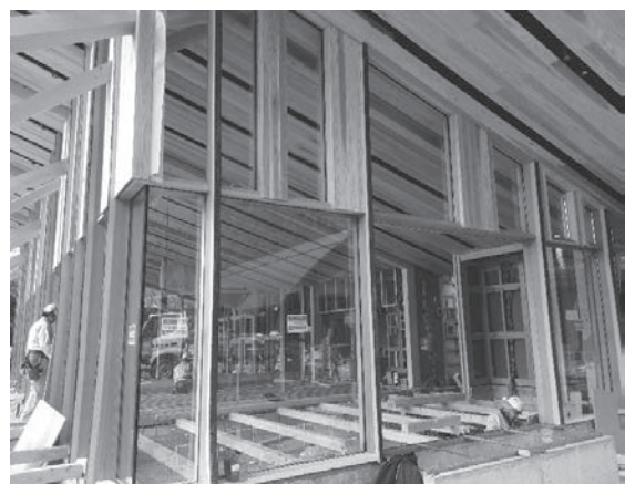
写真 9.50 サッシの取り付け
