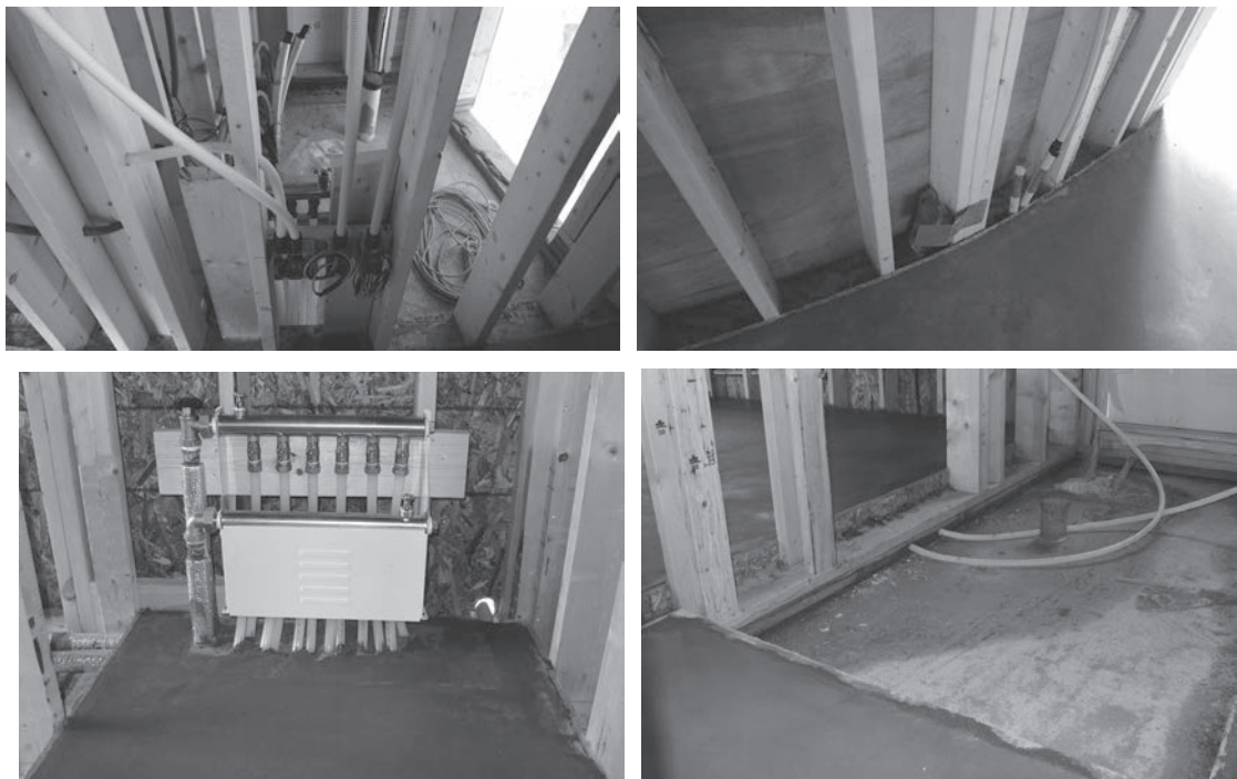
写真 9.25 1 階床 オンドル（温水循環式）の施工と配管
