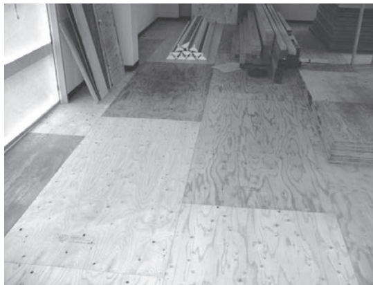
写真 9.27 床合板の施工
