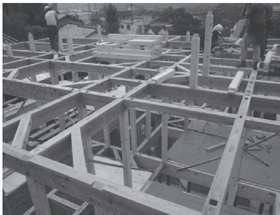
写真 9. 34 小屋束、母屋の施工
