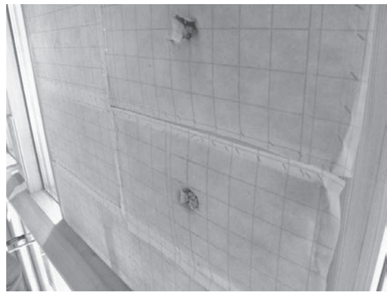
写真 9.41 外壁断熱材
