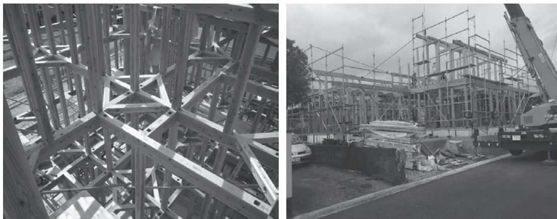
写真 9.32 2階柱の施工
