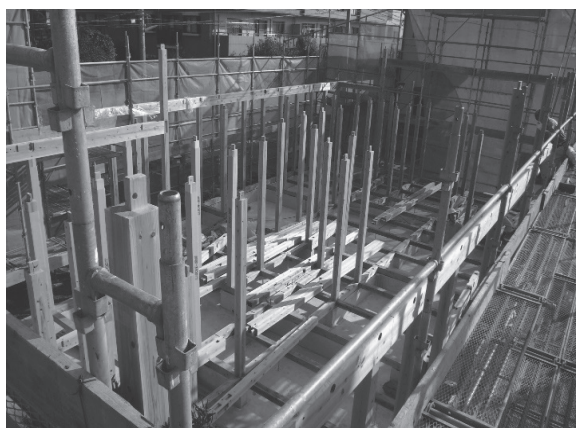
写真 9.28 1階柱の施工
