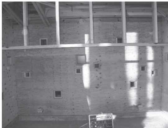
写真 9.48 耐力壁（構造用合板）
