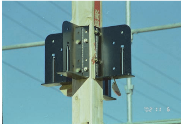
写真 5.4 一枚刃の梁受け金物の例
