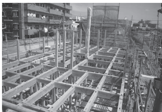
写真 9. 29 2 階床梁の施工
