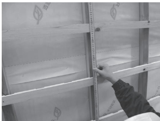
写真 9.45 壁の通気層（縦桟）
