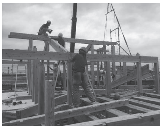
写真 9. 34 小屋束、母屋の施工
