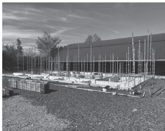
写真 9.21 仮設足場の設置
