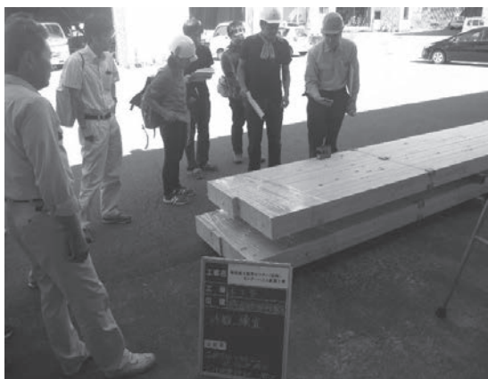
写真 9.16 木材の受け入れと寸法検査
