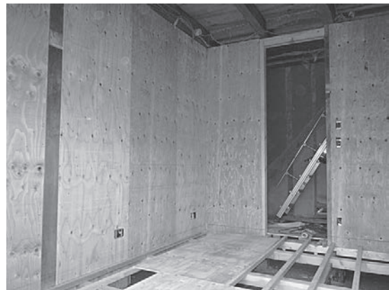
写真 9.48 耐力壁（構造用合板）
