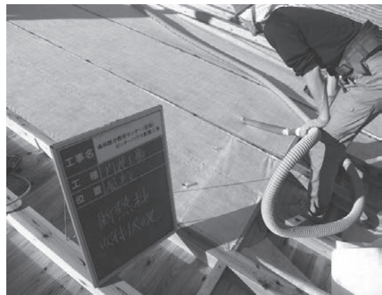
写真 9.43 屋根断熱材
