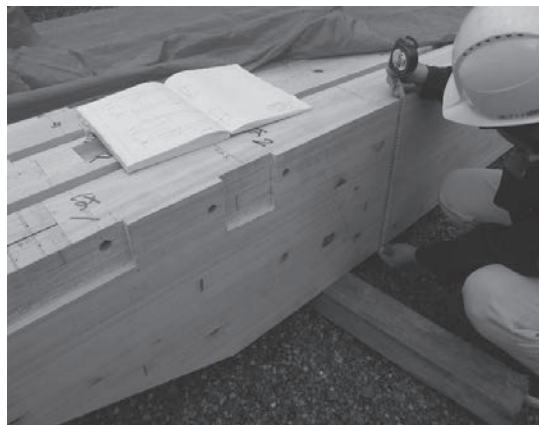
写真 9.16 木材の受け入れと寸法検査
