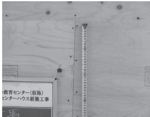
写真 9.36 屋根下地の野地板（構造用合板）の施工
