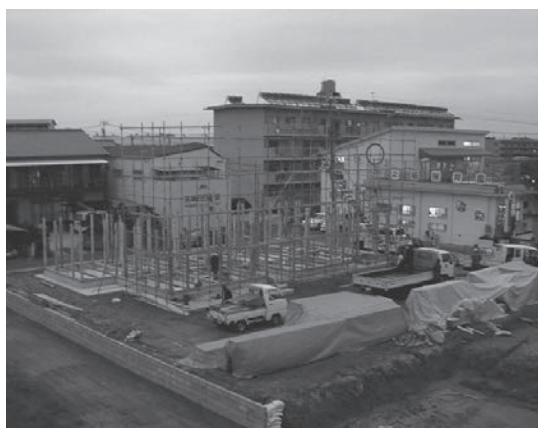
写真 9.28 1階柱の施工
