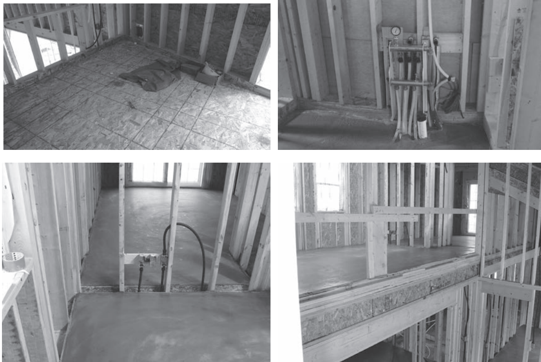
写真 9.31 2階床オンドル（温水循環式）の施工と配管
