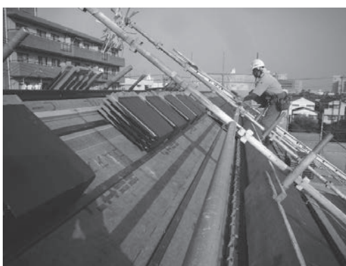
写真 9.39 屋根葺き材の施工
