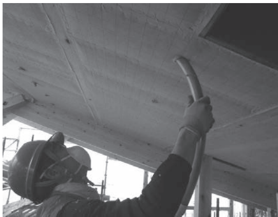
写真 9.42 天井断熱材
