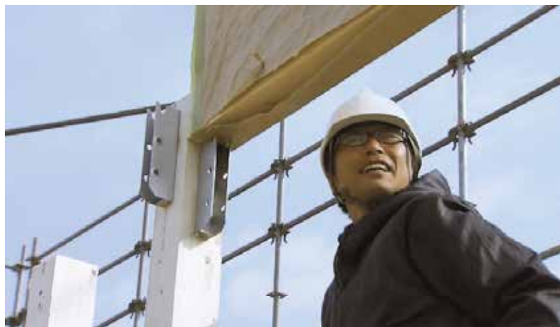
사진 5.3 보받침 철물에 횡가재를 설치
