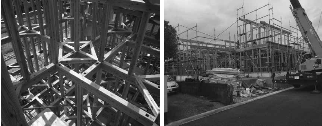
사진 9.32 2층 기둥 시공
