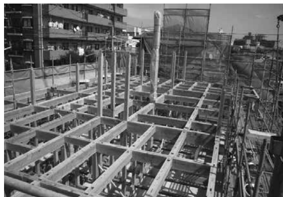
사진 9.29 2층 바닥보의 시공
