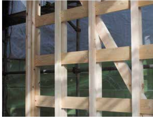
그림 1.2 관목(풍압력이나 지진에 저항한다) 초석 위에 기둥을 설치함
