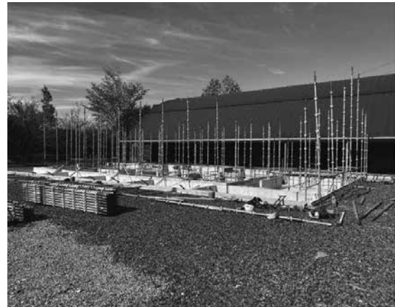
사진 9.21 가설발판 설치
