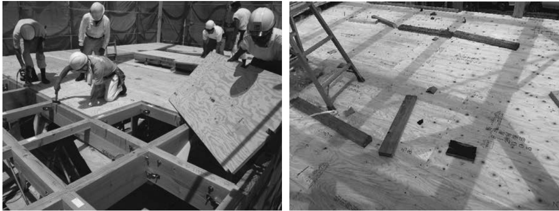
사진 9.30 2층 바닥판의 시공
