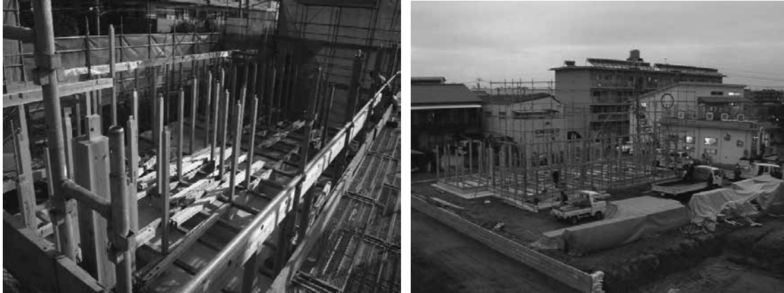
사진 9.28 1층 기둥 시공
