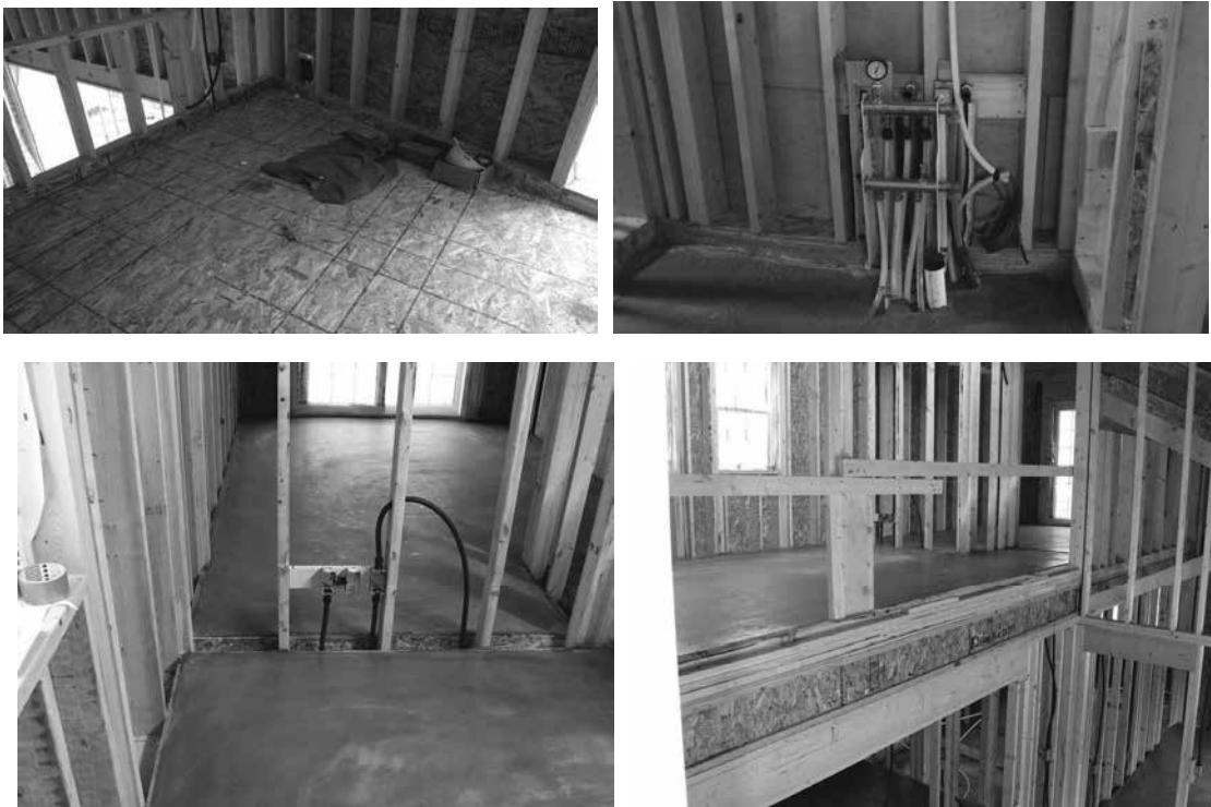
사진 9.31 2층 바닥 온돌 (온수순환식) 시공과 배관
