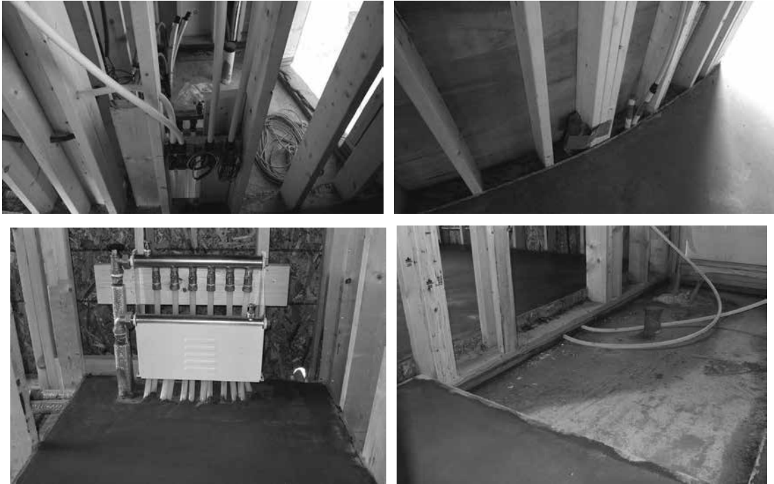
사진 9.25 1층 바닥 온돌 (온수순환식) 시공과 배관
