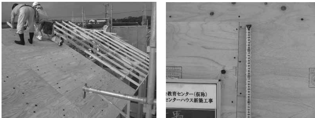
사진 9.36 지붕 밑바탕의 지붕판 (구조용합판) 시공
