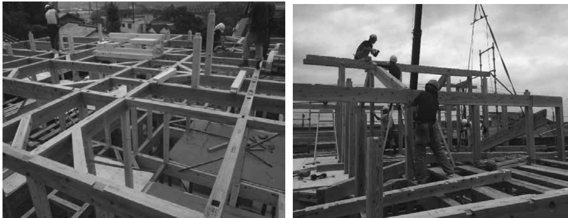
사진 9.34 지붕트러스, 중도리 시공
