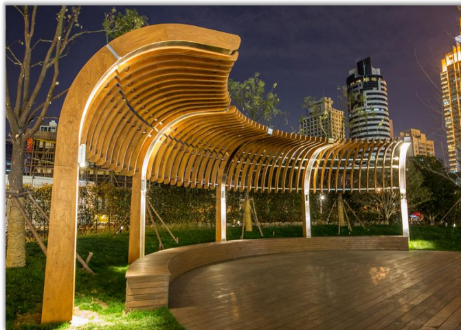
上海南京西路恒隆広場にある屋外構築物
