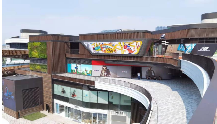
上海市内の商業モールの外装（スギ、ヒノキのサーモウッド、難燃処理）
