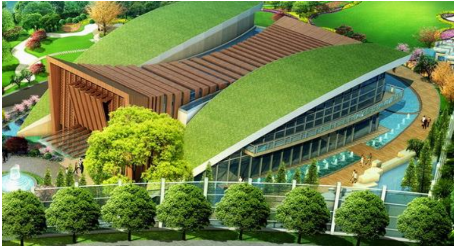
上海郊外にある企業の集会場の外装（スギのサーモウッド、難燃処理）
