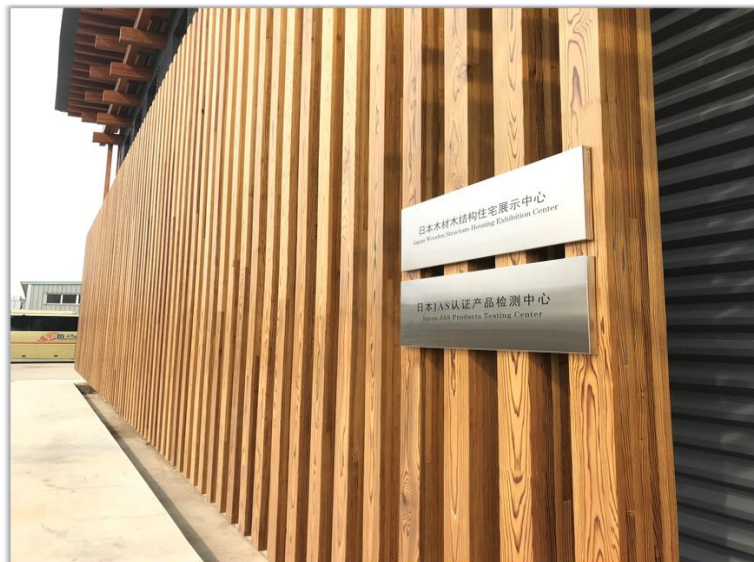
大連市にある鋼構造総合ビルの外装（スギのサーモウッド）
