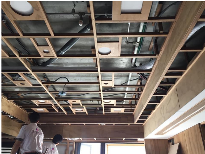
熱処理木材を使用した天井板(上:公共建築物 下:住宅)
