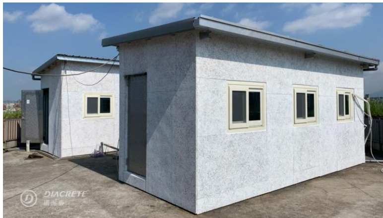
木質セメント板を使用した建築物の外壁
