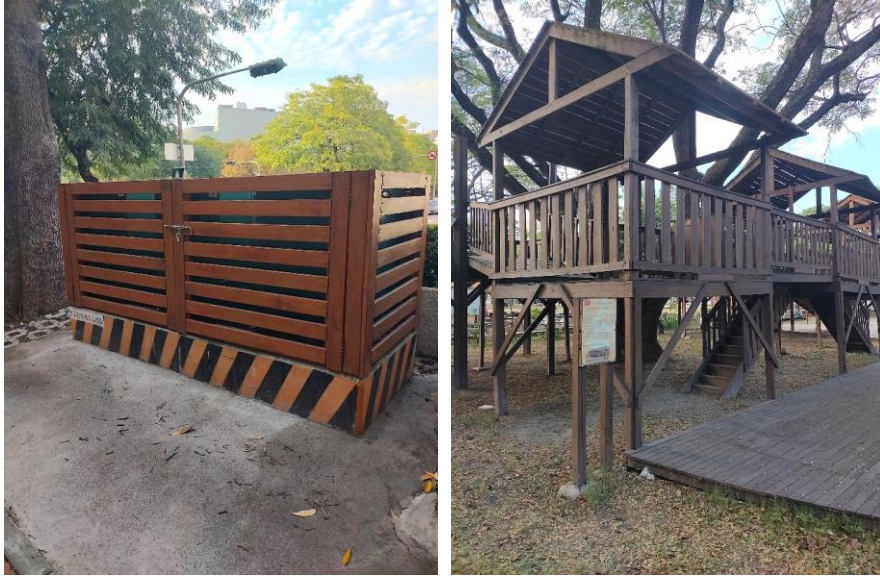
防腐・防蟻処理木材を使用したフェンス（左）、遊具（右）
