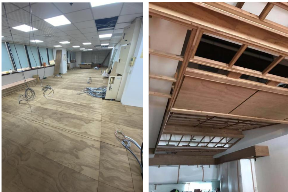
熱処理木材を使用したフローリング(左)、天井板(右)(集森実業股份有限公司)
