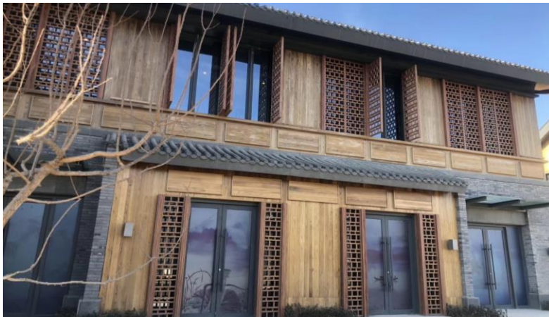
山東省のある混合構造建築物の外装（スギのサーモウッド）
